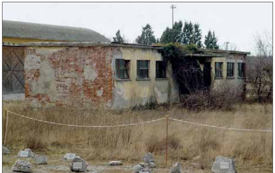
Il complesso delle baracche fu demolito negli anni '80; sono visibili solo le fondamenta, alcuni bagni comuni, i magazzini.
